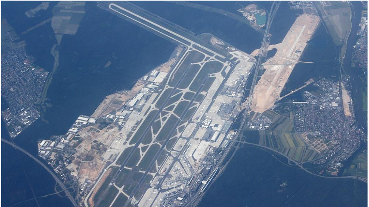
Rechts oben im Bild die Baustelle der Landebahn Nordwest am 27.06.2010 (Quelle: Ch. Weber)
