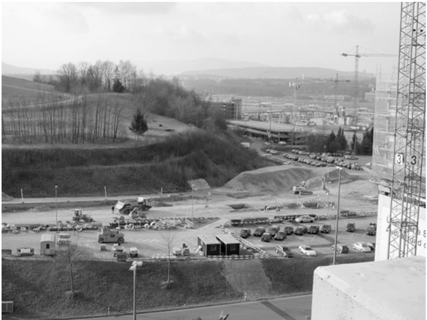
Die Auswirkungen des Flughafens werden an den Messstandorten vom Strassenverkehr überlagert, aber auch von grossen Bauarbeiten.
