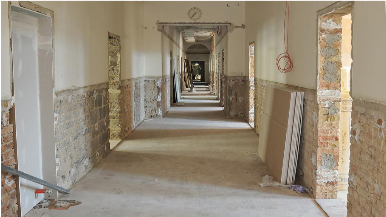
Für das Informationszentrum wurde ein Gebäude des ehemaligen Enka-Werks in Kelsterbach entkernt und umgebaut. (Quelle: UNH)
