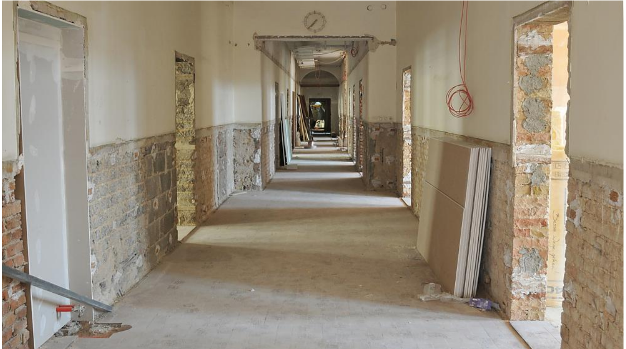
Für das Informationszentrum wurde ein Gebäude des ehemaligen Enka-Werks in Kelsterbach entkernt und umgebaut. (Quelle: UNH)
