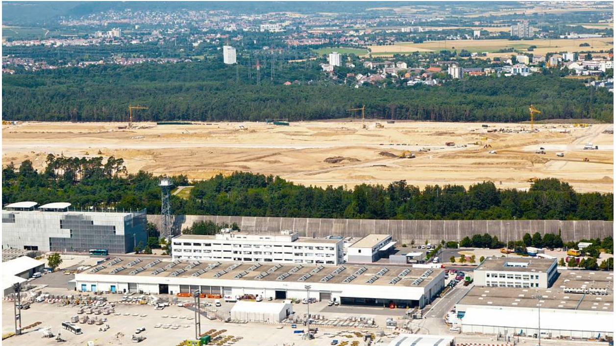
Baustelle der Landebahn Nordwest im Juli 2010 (Quelle: iStockphoto / Meinzahn)
