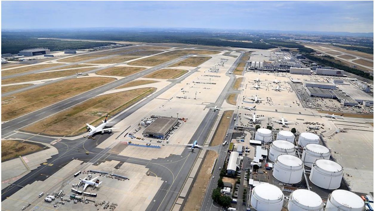
Der Frankfurter Flughafen aus der Luft. Rechts vorne zehn Kerosintanks mit einem Fassungsvermögen von 186 Millionen Litern. (Quelle: Fraport AG / Fototeam Stefan Rebscher)
